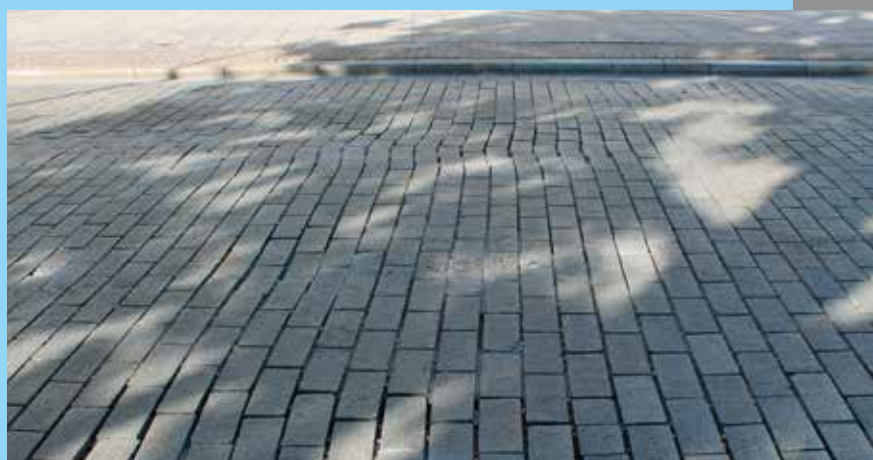
Krakowskie Przedmieście na wysokości skweru Hoovera. Kamienna nawierzchnia ulega przesunięciom i nierównomiernie osiada pod wpływem ruchu ciężkich pojazdów.
