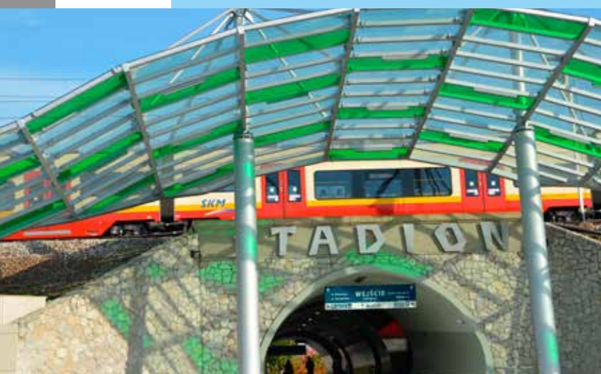
Pociąg SKM Warszawa na przystanku Stadion
