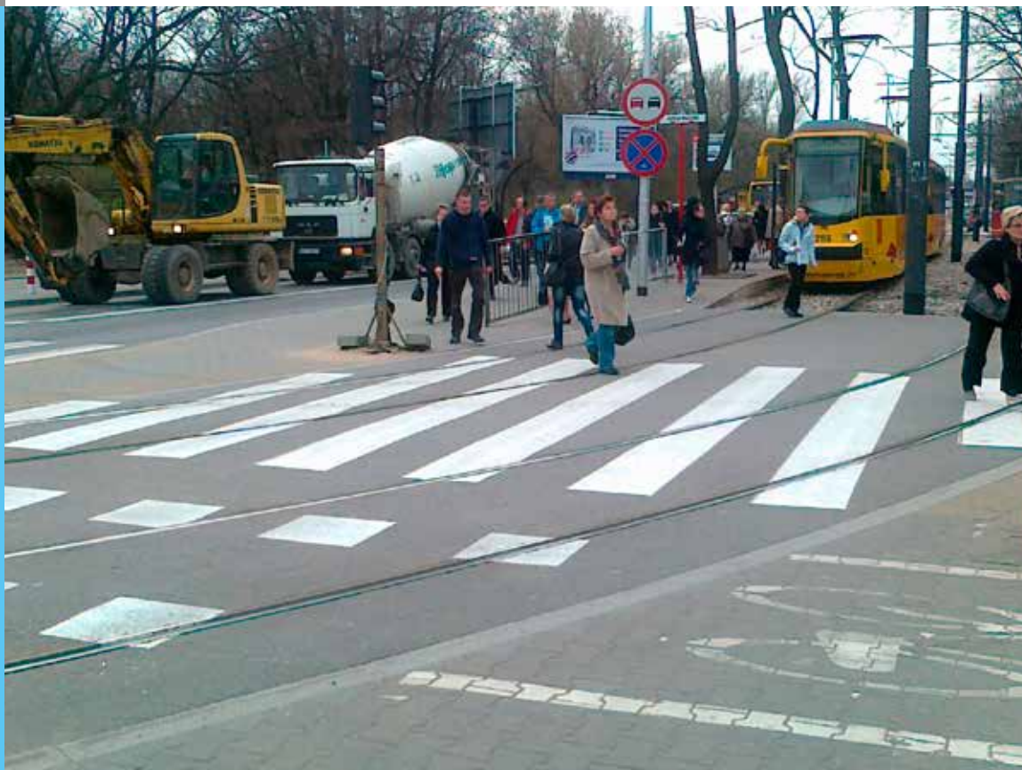
Przykłady niepotrzeb- nych przeszkód utrudniających ruch pieszych
